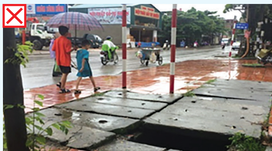
Cống thoát nước công cộng không có nắp đậy, hồ chôn cột điện không lắp
