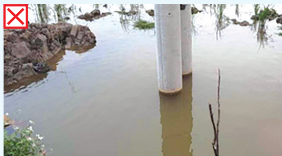
Cống thoát nước công cộng không có nắp đậy, hồ chôn cột điện không lắp
